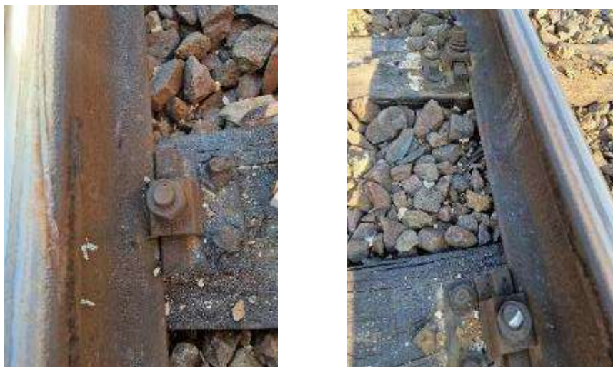
Foto nr.2, urmele de escaladare și cădere a primei osii a locomotivei
