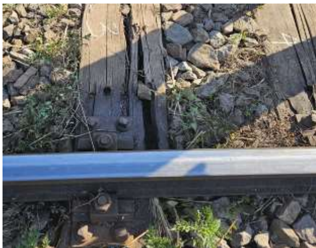
Foto.nr.11 – Traversele T 3 , T 4
