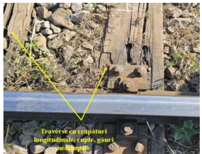
Foto.nr.12 – Traversele T 3 , T 4
