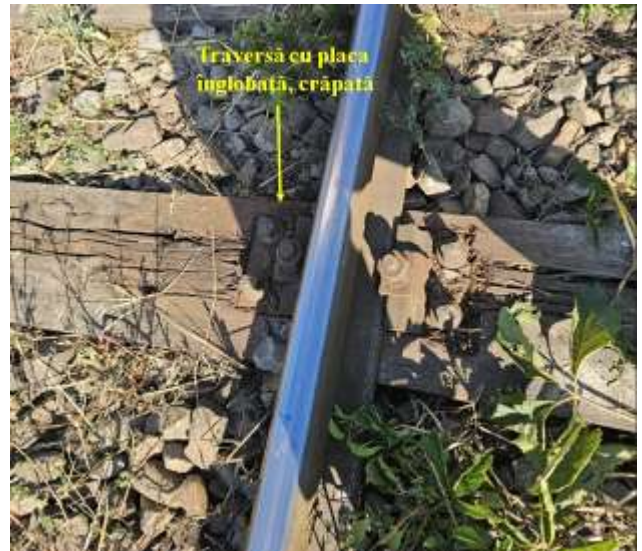
Foto.nr.10 – Traversa T 2 cu placa înglobată
