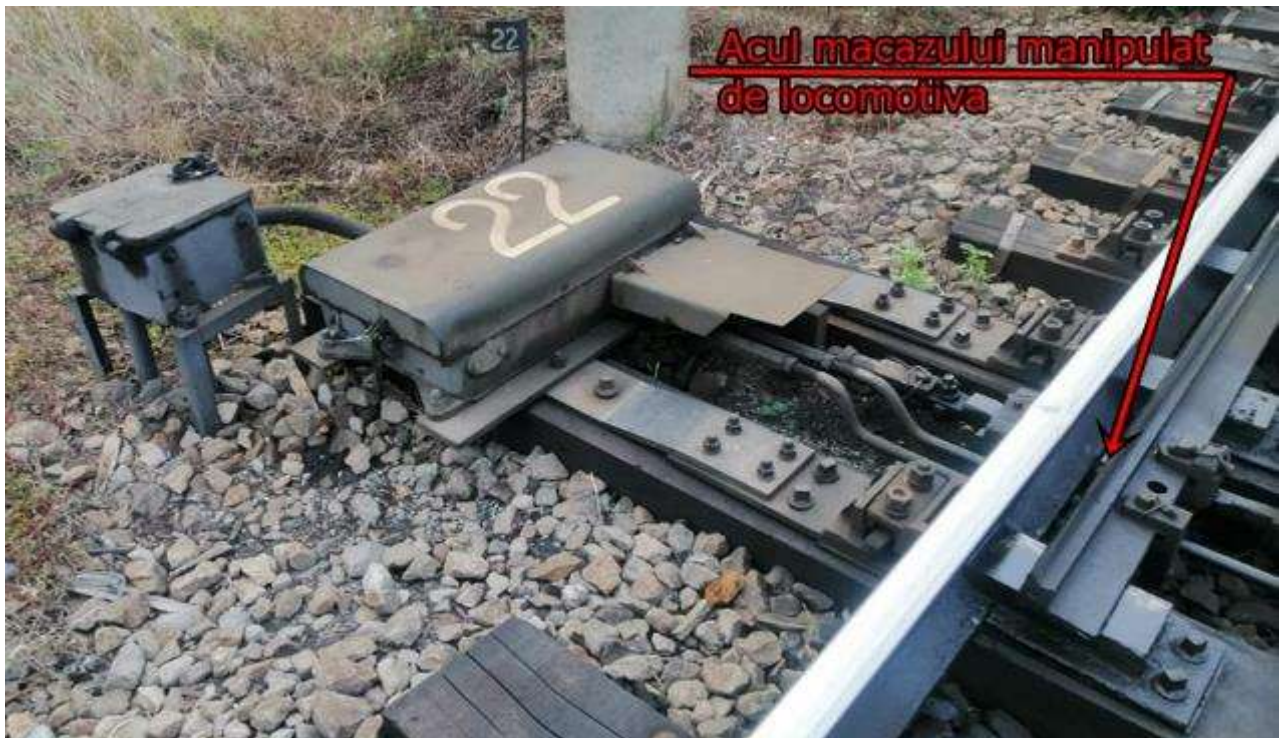
Foto nr.3 Macazul schimbătorului de cale nr.22
