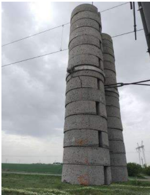
Foto nr.7 și 8 Urme de vopsea pe contragreutatea de compensare a stâlpului LC SH 59
