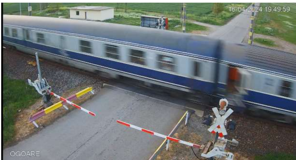
Foto nr.5 si 6 Trecerea la nivel cu cale ferată la km 118+124 între stația CFR Ciulnița și Hm Perișoru
