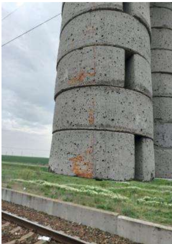
Foto nr.7 și 8 Urme de vopsea pe contragreutatea de compensare a stâlpului LC SH 59
