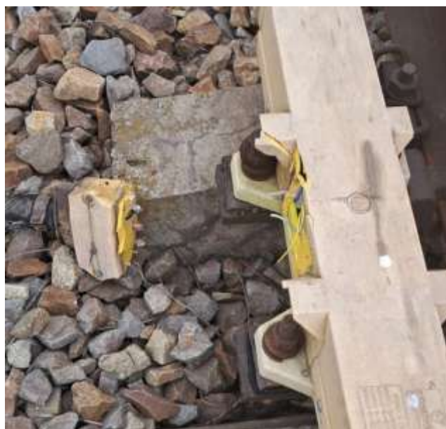
Foto nr.7 Inductor cale 500 Hz semnal PrX halta de mișcare Gălăteni
