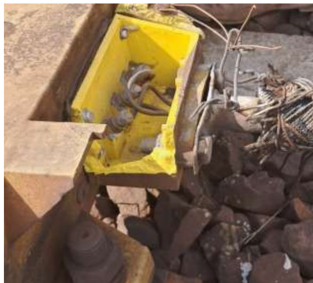
Foto nr.5 Inductor cale semnal luminos X halta de mișcare Gălăteni
