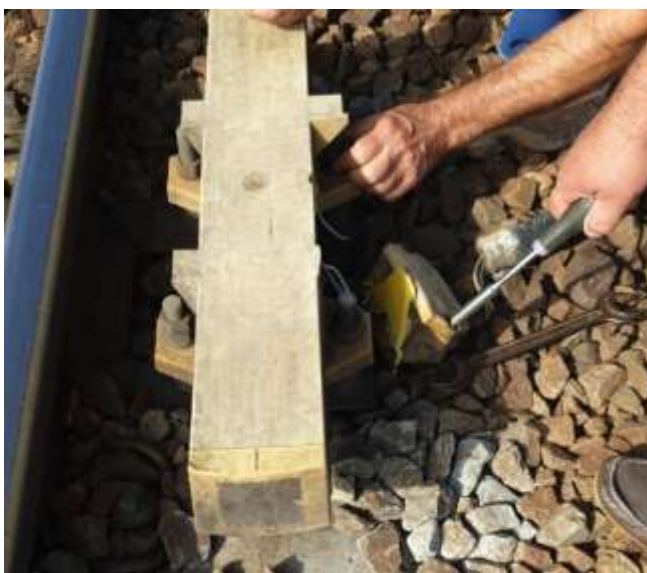
Foto nr.4 Inductor cale semnal luminos XIII halta de mișcare Gălăteni
