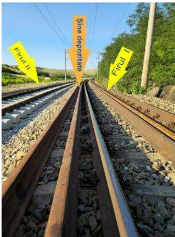
Imaginea nr.6– Imagine șine depozitate pe capătul traverselor Firului I
