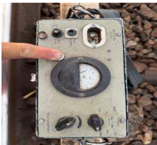
Foto nr.3 Inductorul de cale 1000/2000Hz aferent semnalului de intrare YA
