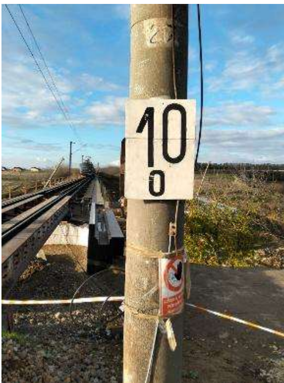
Foto nr.1 Indicatorul permanent de viteză Viaduct Cârcea
