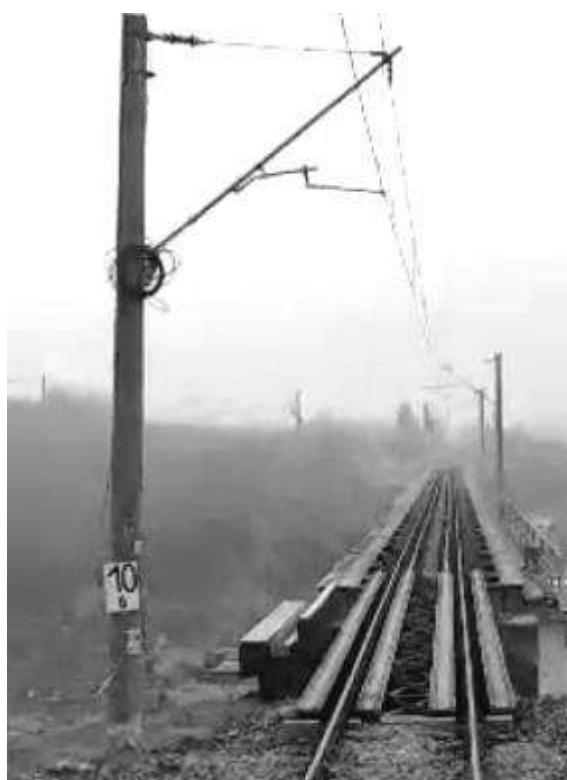
Foto nr.2 Indicatorul permanent de viteză Viaduct Cârcea
