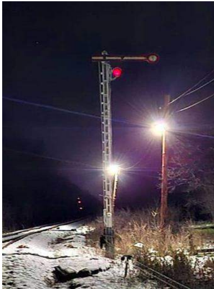
Foto nr.2 Semaforul de ieșire al Hm Romula cu indicația „ OPREȘTE fără a depăși semnalul! ”
