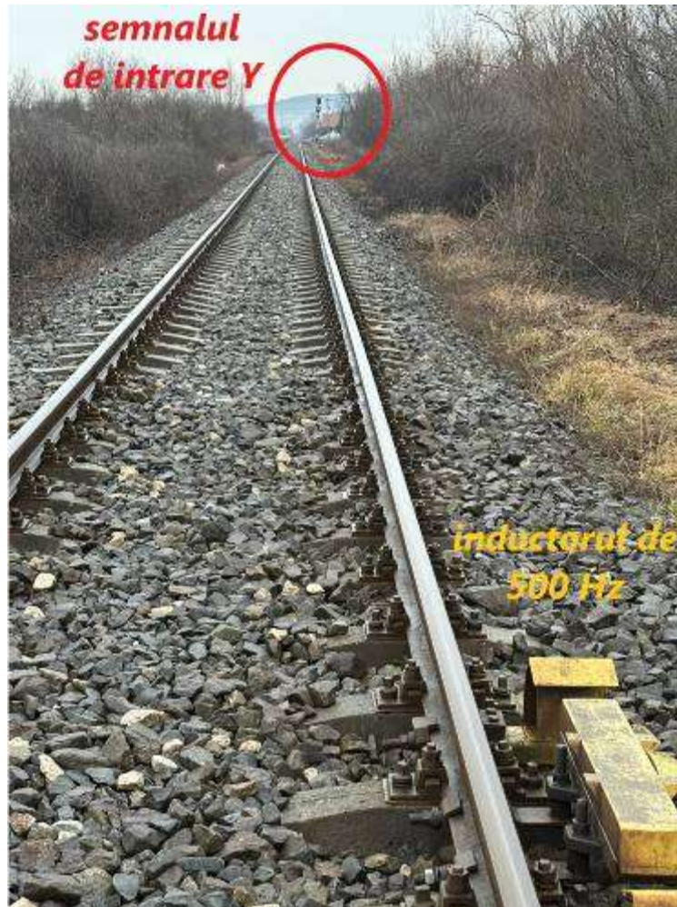
Foto nr.7 – vizibilitatea semnalului din zona inductorului de 500 Hz
