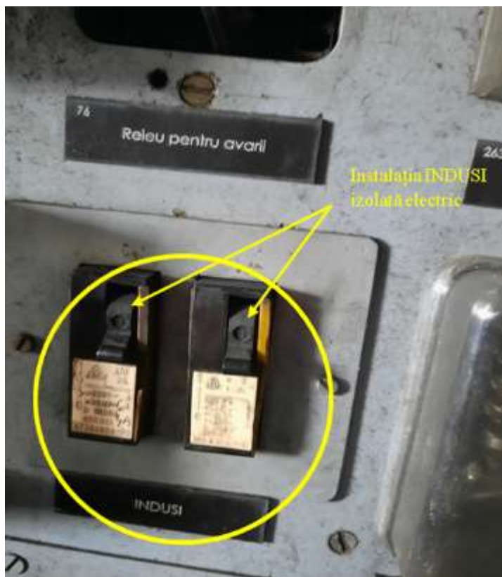
Foto nr.3 Instalația INDUSI izolată
