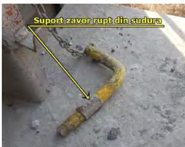
Foto nr.6 Zăvor cu suport pe peronul vagonului
