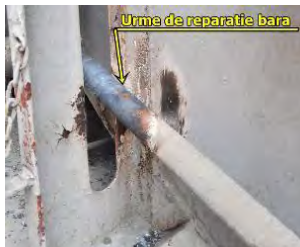
Foto nr.9 Bară de acționare clapă descărcare partea stângă sens mers.
