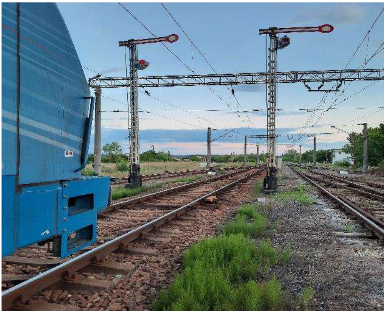
Foto nr.2 Poziția și indicația semaforului de iesire, al stației CFR Amaradia. „OPREȘTE fără a depăși semnalul!” Ziua—brațul orizontal spre dreapta sensului de mers
