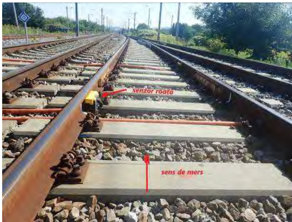
Foto nr.4 – componente senzor roată (sursa: Manual de montare, punere în funcțiune și întreținere – Frauscher)
