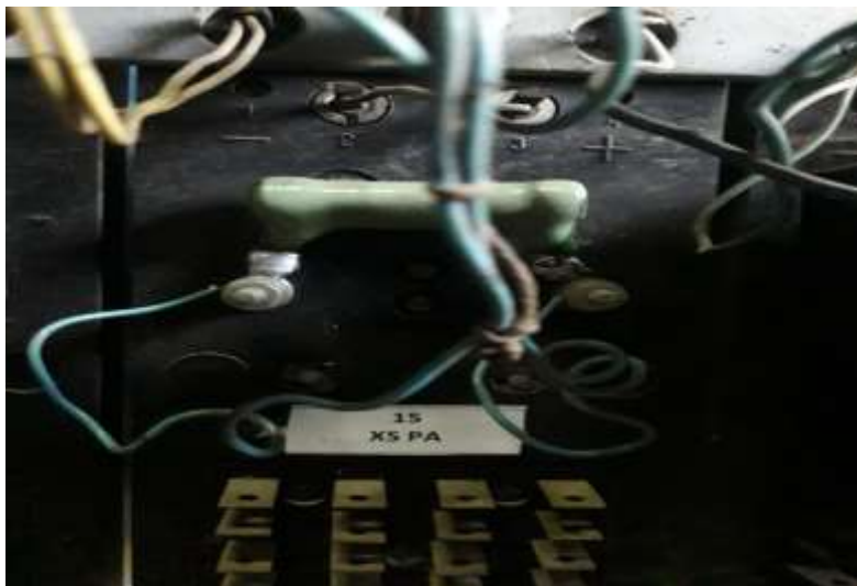
Foto: 7 Rezistența de 75 ohmi din schema releelor KSC
