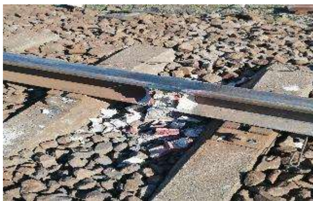
Foto nr.2 sudura aluminotermică a acestuia
