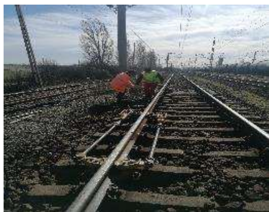
Foto nr.1 Pretensionarea șinei
