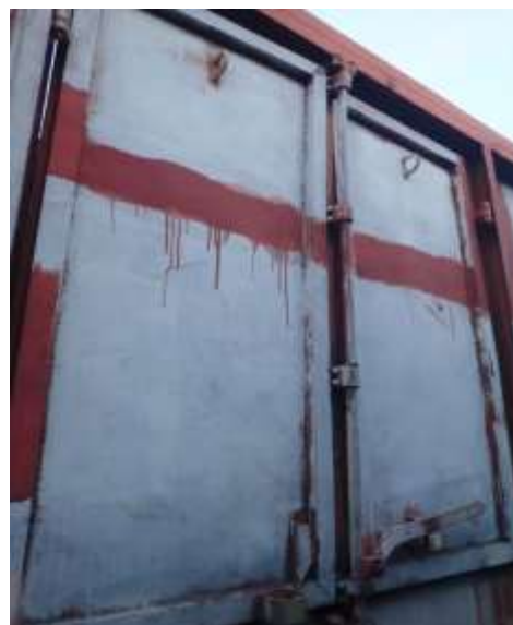
Foto nr.4 Ax central acționare uși deformat la partea superioară
