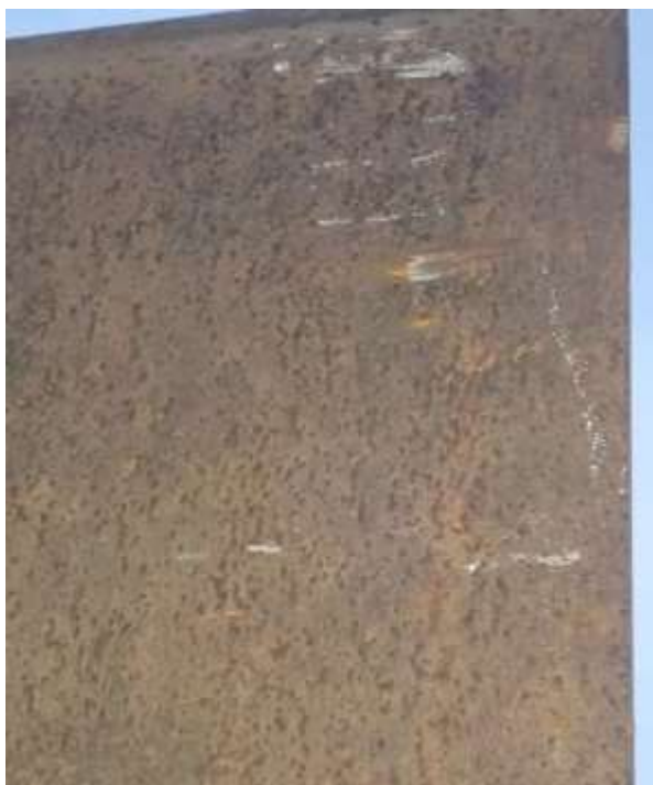
Foto nr.7 Urme lovire pe partea interioară a celei de-a doua uși
