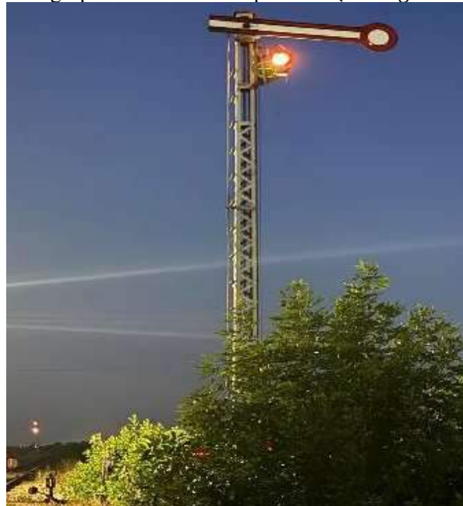
Foto nr.3 Semaforul de ieșire de grup B1
