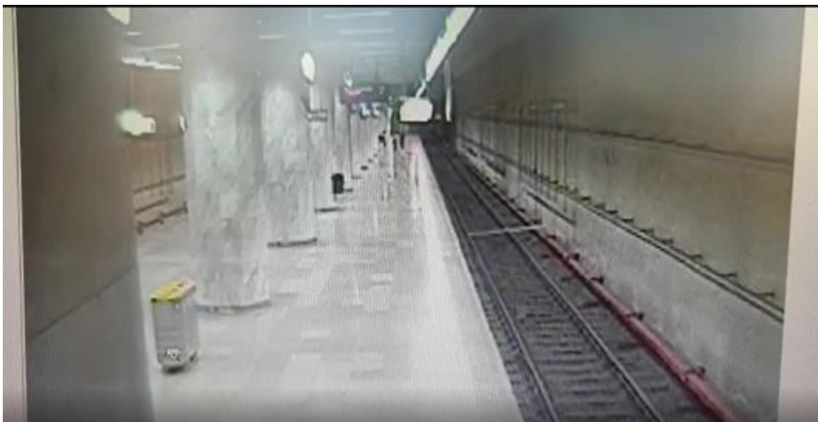
Figura 2. Riflajul căzut în calea de rulare, stația 1 Mai, fir 1
