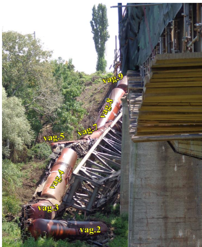
vagoanele nr.2-nr.9 (vagoanele nr.5, nr.7 și tablierul stau peste vagonul nr.6)
